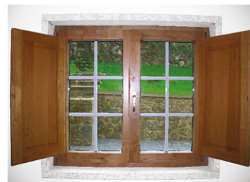
AS PORTADAS INTERIORES COM PORTADAS DE MADEIRA É MAIS COMUM EM EDIFÍCIOS ANTIGOS.
