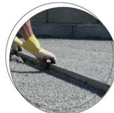
Betoniilha com isolamento térmico
