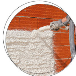
Argamassa Térmica condutibilidade: 0,050
